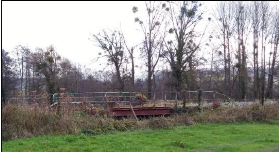
Figure 2 : Ligne 325 000 – Photographie de l'ouvrage au Pk 143+148
