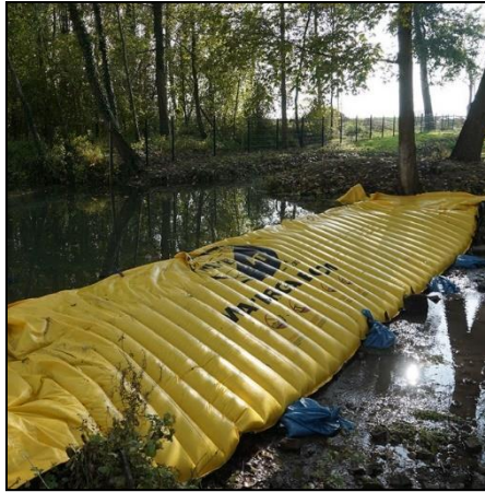
Figure 11 : Ligne 325 000 – Exemple de batardeaux de type Watergate
