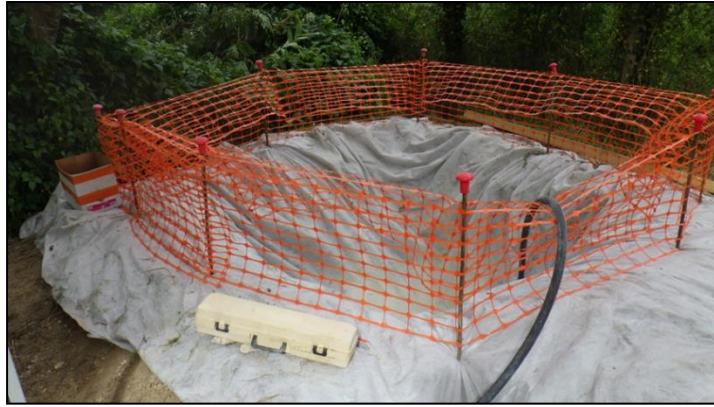
Figure 13 : Ligne 325 000 - Exemple d'un bassin de décantation provisoire pour les eaux d'exhaure de batardeaux
