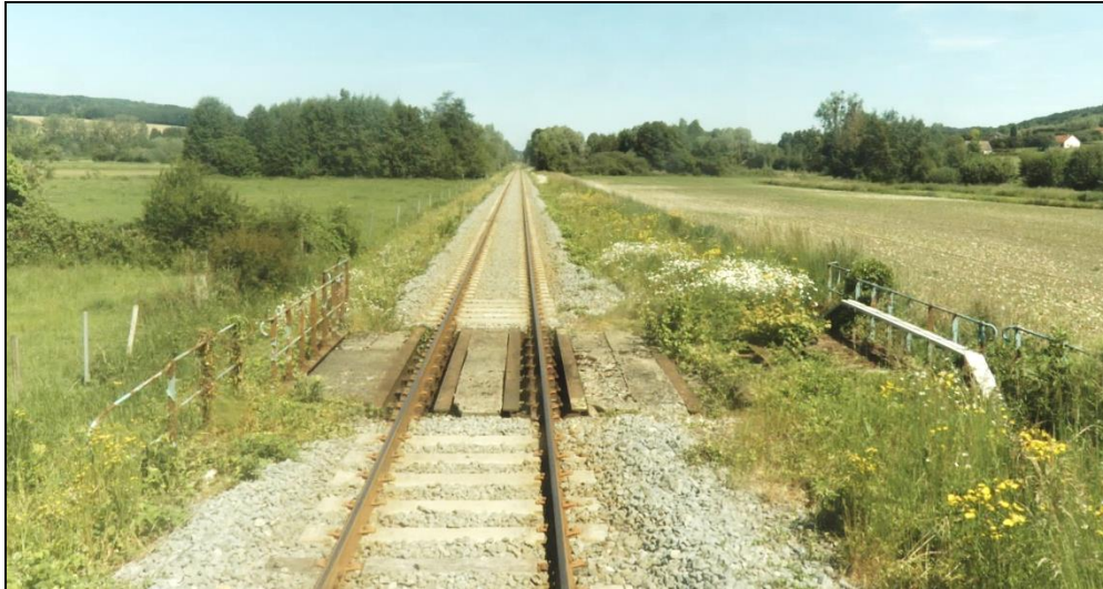
Figure 4 : Ligne 325 000 – Photographie de l'ouvrage au Pk 143+148
